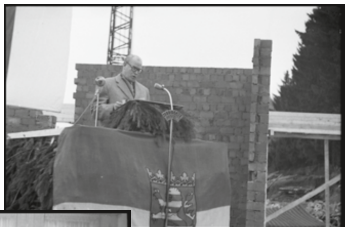
Abb. 2: Ansprache von Ministerpräsident Georg August Zinn zur Grundsteinlegung der Heilstätte Schotten am 20. November 1958
