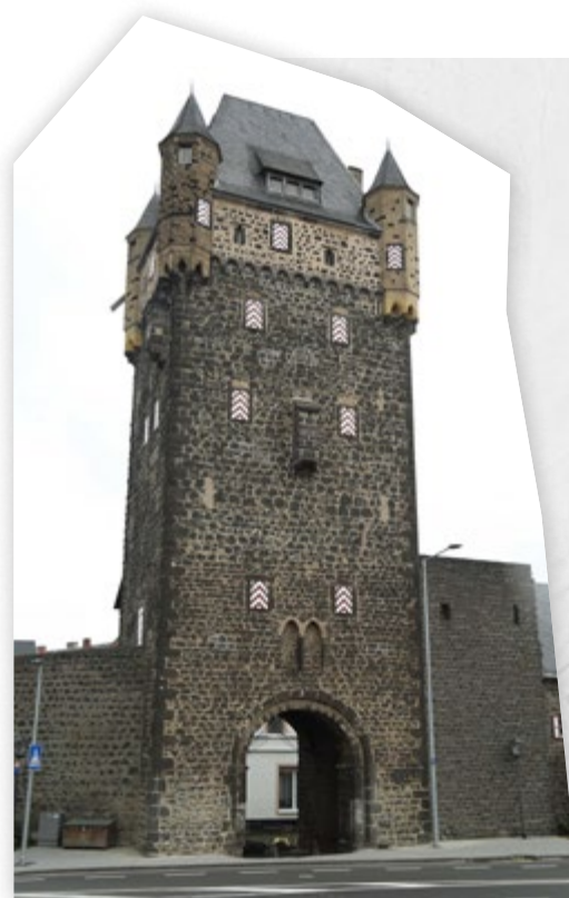
Abb. 3: Als Magazinerweiterung für die Archivkooperation wurde kürzlich das ebenfalls unter Denkmalschutz stehende Obertor in Mayen in Betrieb genommen
