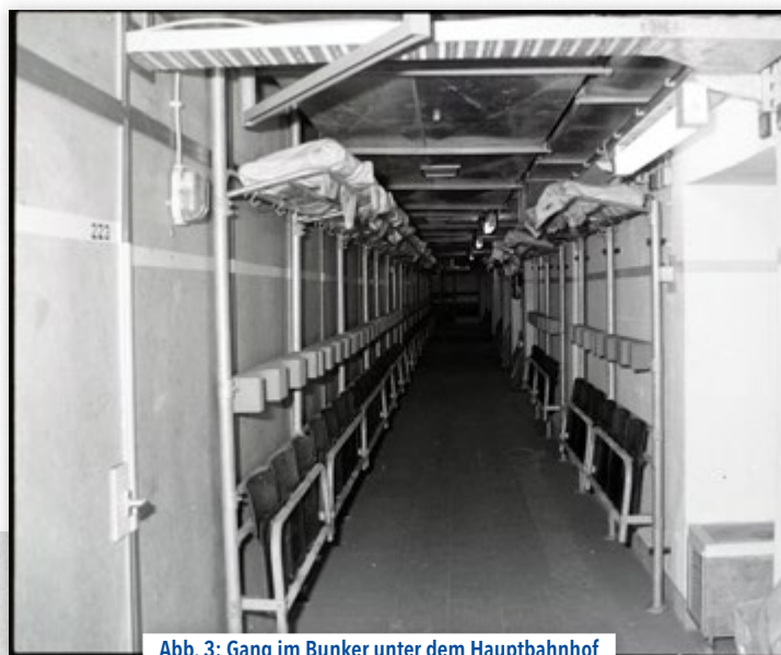
Abb. 3: Gang im Bunker unter dem Hauptbahnhof mit Sitzgelegenheiten
